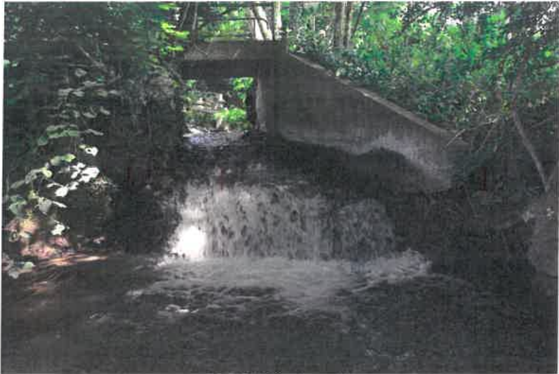
Pont de Glinet avant travaux
