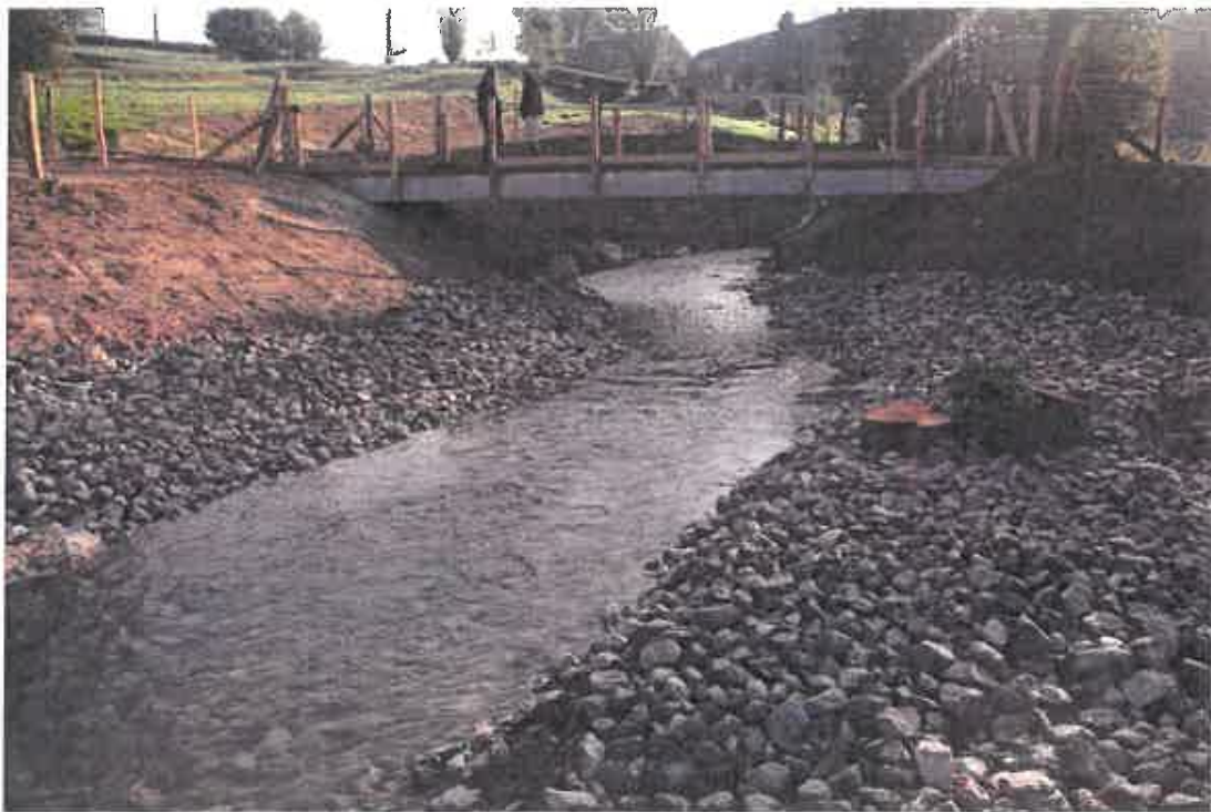
Pont de Glinet après travaux
