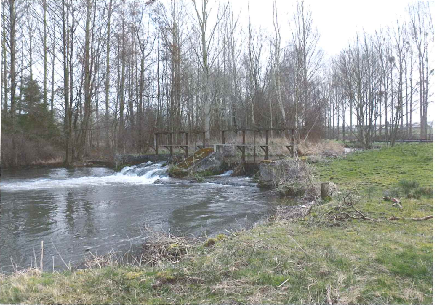
Vannage de décharge du moulin de Penthievre à Blangy-sur-Bresle
