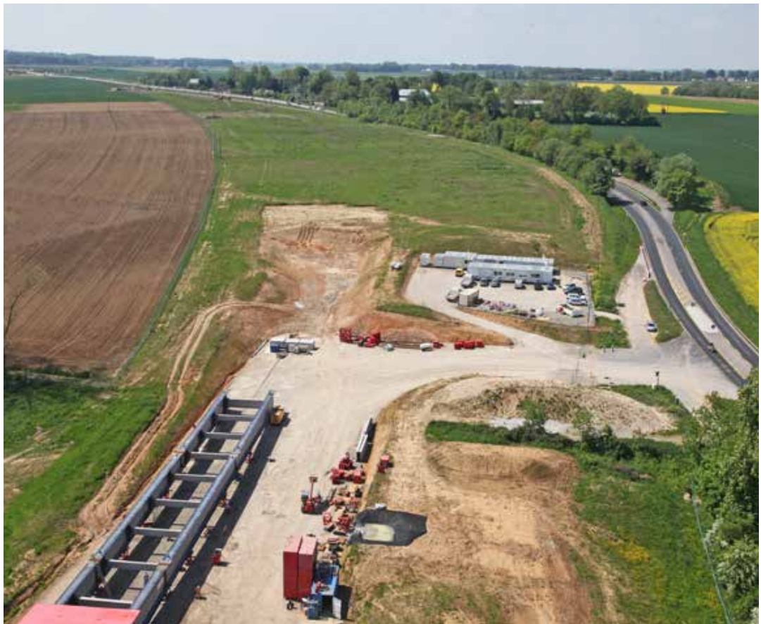
Installation d'un centre de tri des déchets du chantier de l'A150
