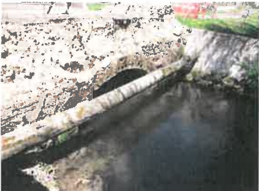
Le pont communal du bras droit (Pont 2)
