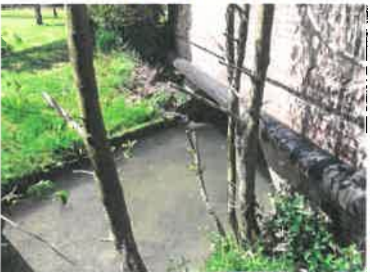
Le pont communal du bras gauche (Pont 1)
