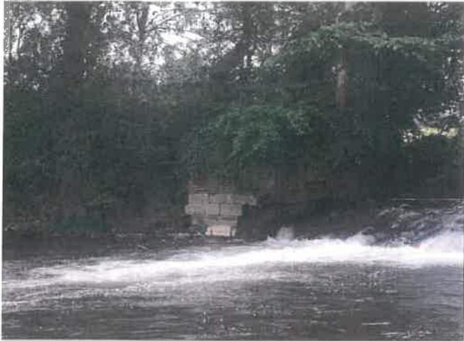
Zoom sur les maçonneries en rive droite
