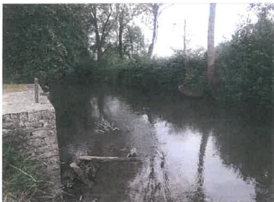
Ancien sarnage de répartition entre le bief du moulin et le bras de dérivation
