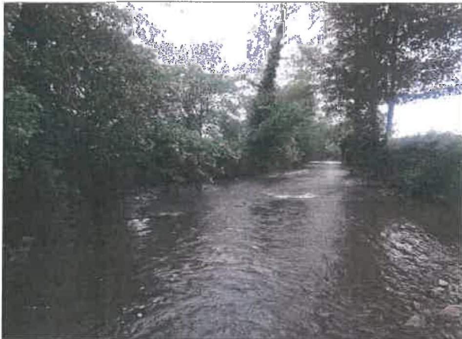
2 ème radier de contrôle en aval de la fosse de dissipation
