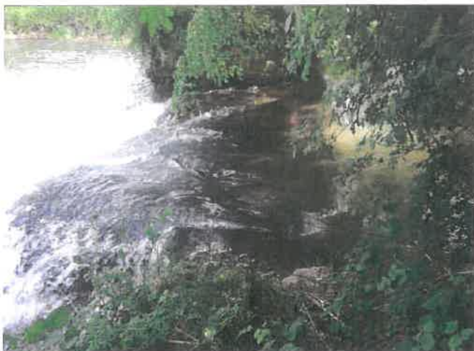
Le seuil résiduel de la chute
