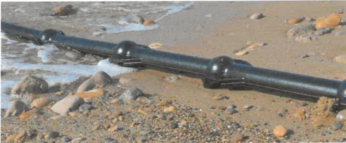
**Figure 5 : Exemple de coquille de protection articulées**
