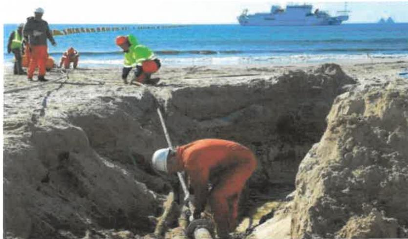
Figure 8 : exemple, passage du câble dans une conduite menant à la chambre d'atterrage
