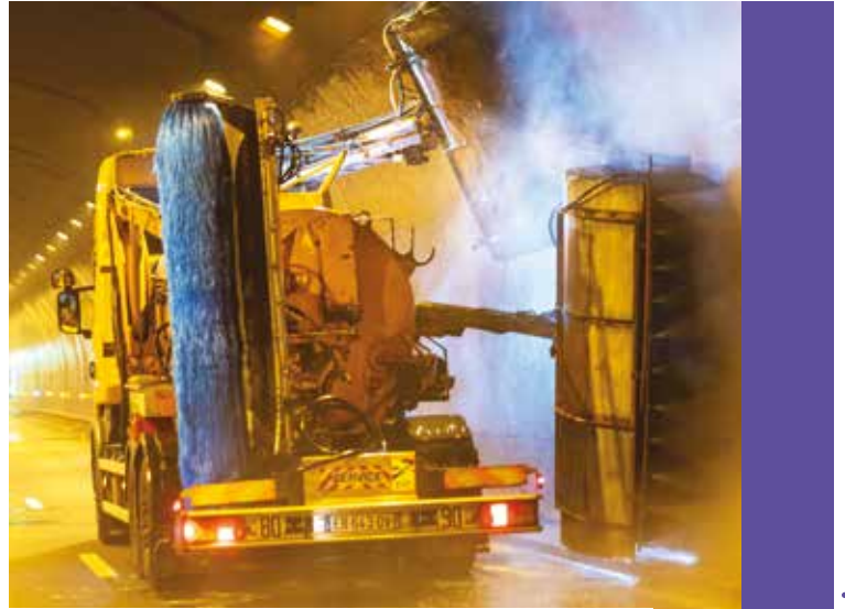
Procéder à un nettoyage des équipements altérés par la pollution liée au trafic (parois et caméras)
