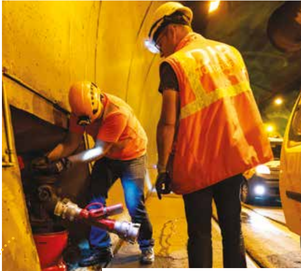
Tester le bon fonctionnement des différents équipements de sécurité
