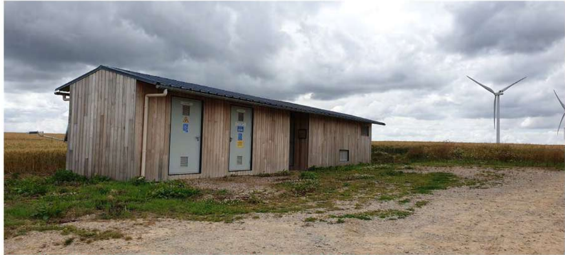
Une silhouette et des couleurs qui rappellent les bâtiments agricoles Un bon exemple qui mériterait un traitement du sol plus soigné, tout en restant rustique et perméable
