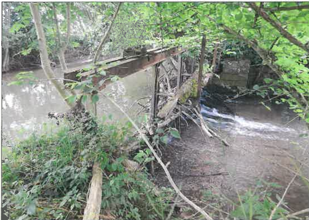
Vue en aval du vannage répartiteur => filet d'eau passant au travers des embâcles
