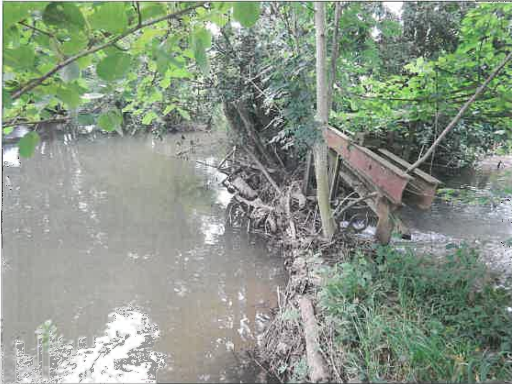
Vue en aval du vannage répartiteur => filet d'eau passant au travers des embâcles
