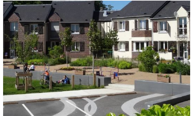
Nantes - Le Clos de l'Erdre (CAUE 76) ▲
